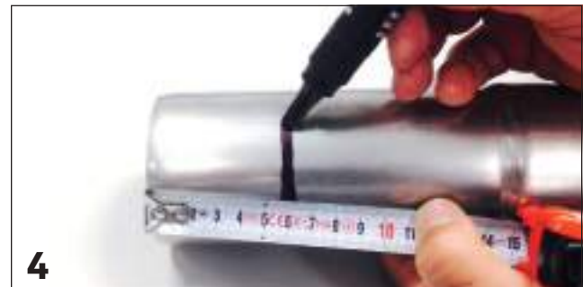
4 Marcatura quota d'innesto / Marking the insertion's depth
